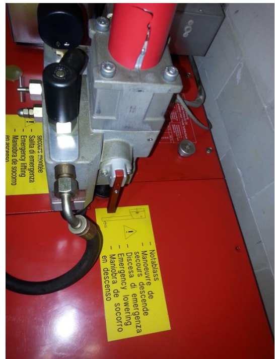
hydraulisch stuurblok op aggregaat
